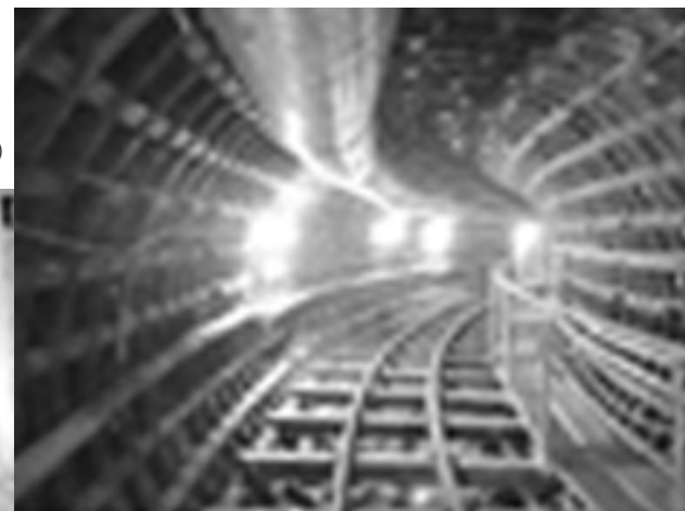
名古屋市の貯留管内部(現在工事中のもの)
